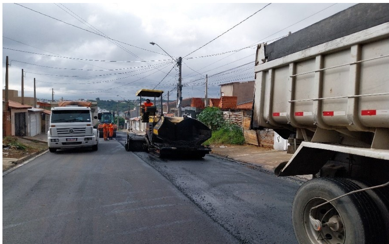
Foto 7 - Carga, descarga e transporte de concreto asfáltico
