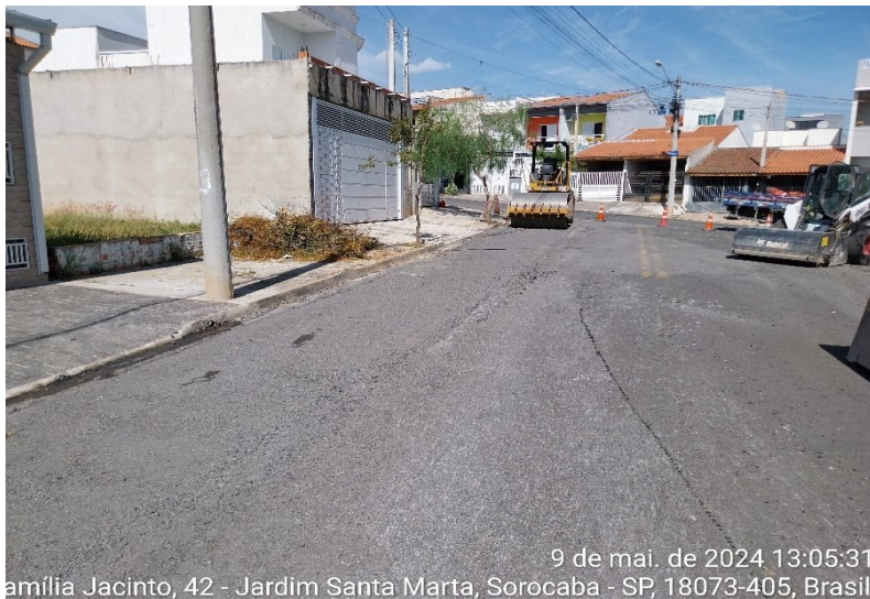
Foto 6 - Tratamento de base com RAP
