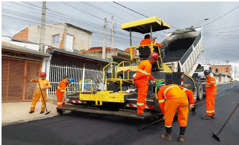
Foto 7 - Carga, descarga e transporte de concreto asfáltico
