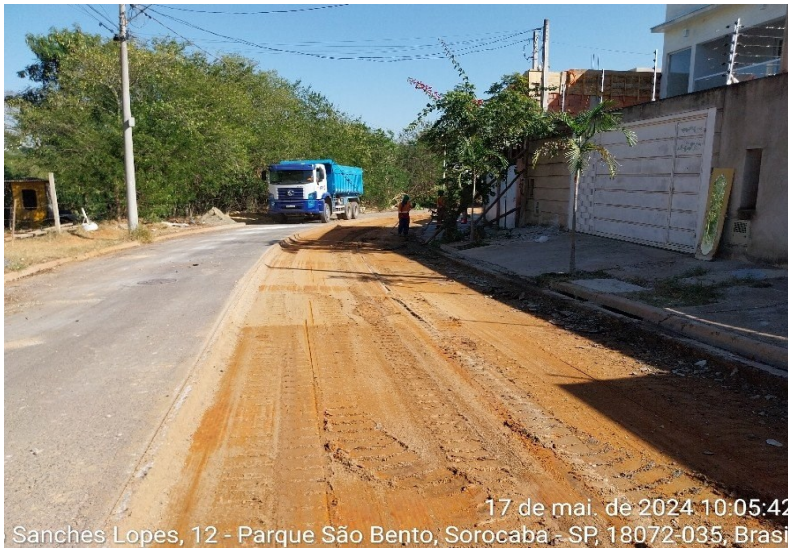
Foto 3 - Abertura de caixa até 25cm
