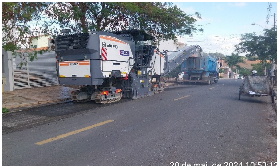
Foto 2 - Fresagem pavimento
