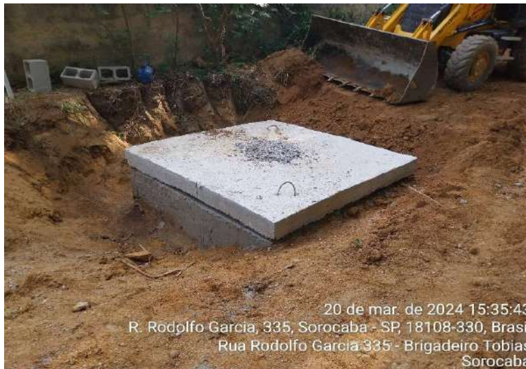
Foto 5 - Execução do PV-24
