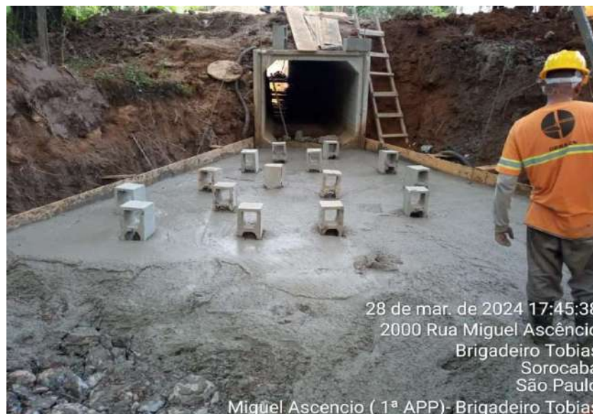
Foto 10 - Concretagem do dissipador
