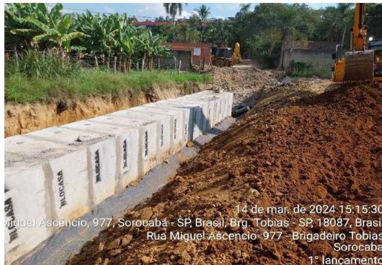
Foto 8 - Execução do dreno lateral
