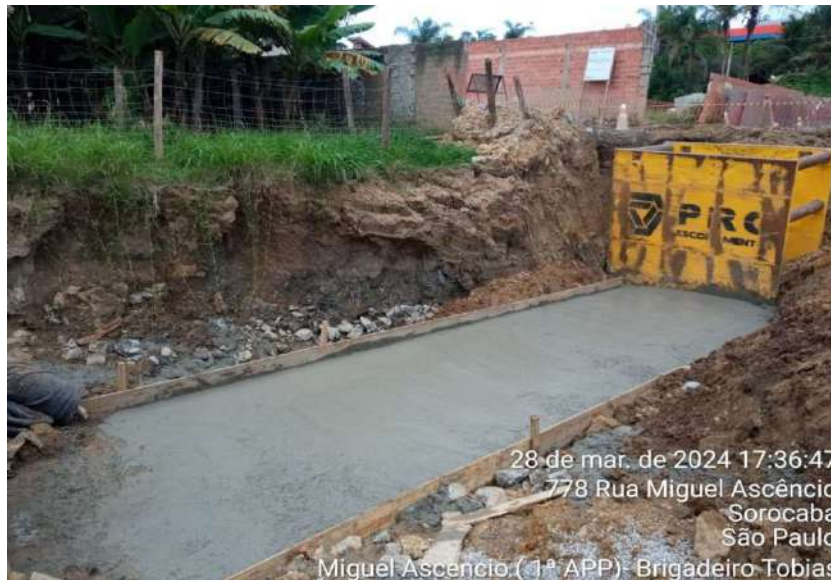
Foto 9 - Concretagem da base para as aduelas
