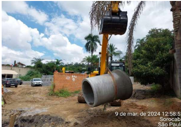
Foto 4 - Assentamento de Tubos de 1000mm
