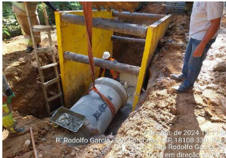
Foto 2 - Assentamento de Tubos de 800mm
