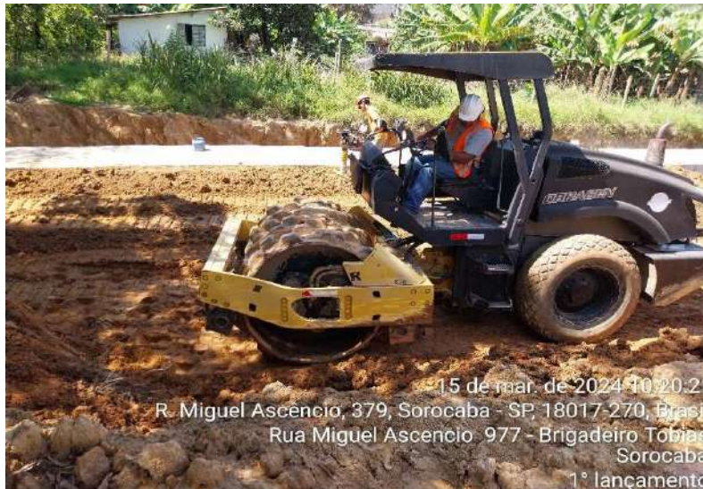
Foto 7 - Compactação de solo com rolo compactador pé de carneiro
