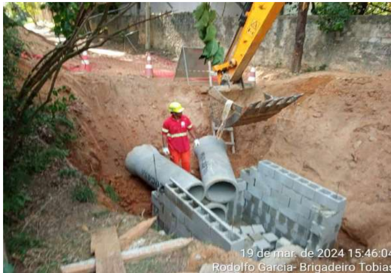
Foto 3 - Assentamento de Tubos de 500mm e 600mm
