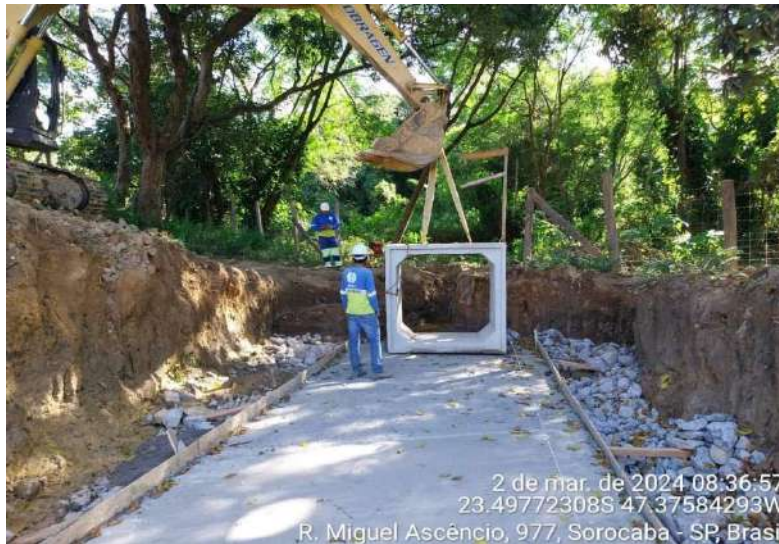
Foto 1 - Assentamento de Aduelas 1,50 x 1,50 m
