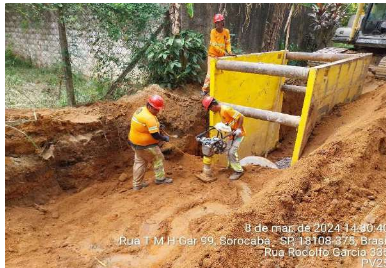
Foto 6 - Compactação de solo com sapo compactador
