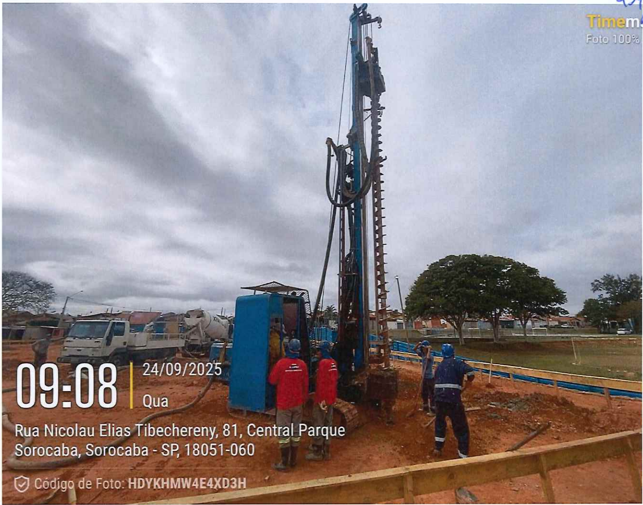
Perfuração de estacas hélice continua
