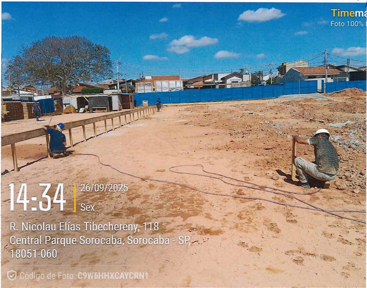
Transferência de nível PA para locação de formas
