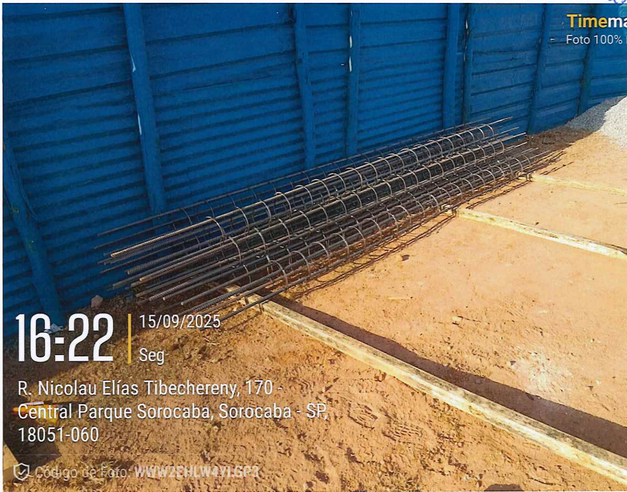
Armação de ferragens de estacas
