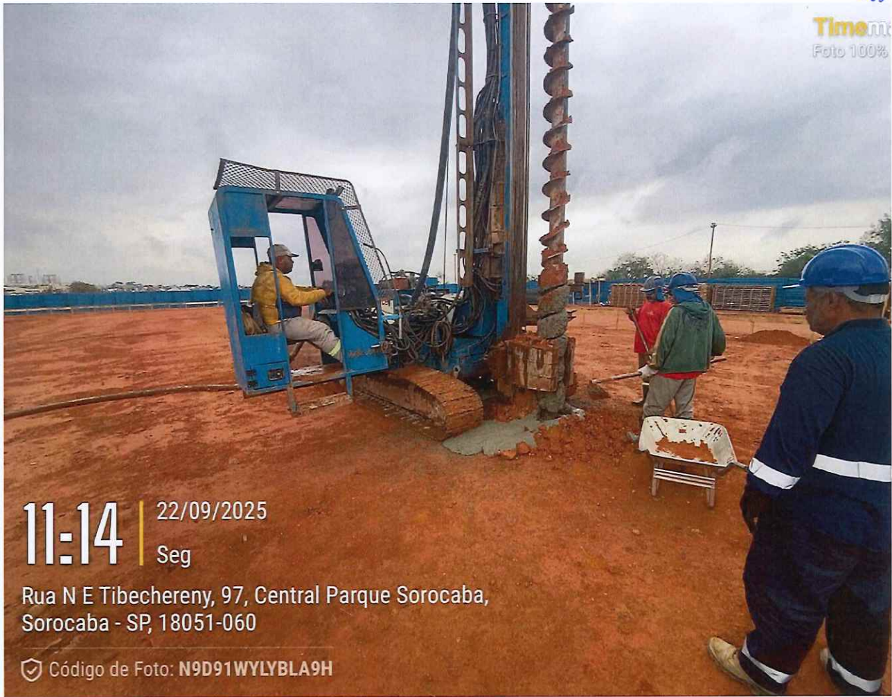
Perfuração de estacas hélice contínua
