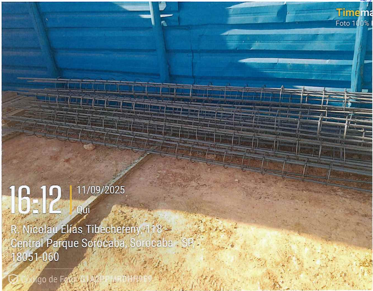
Armação de ferragens de estacas
