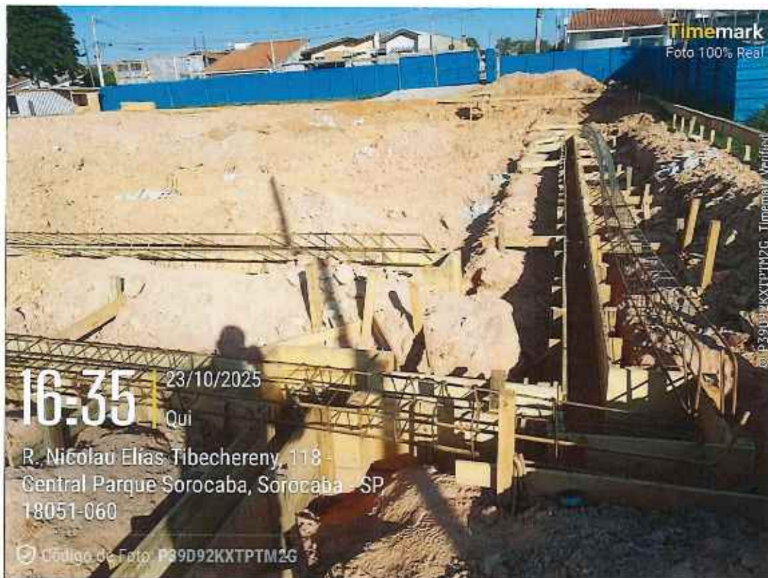
Armação de ferragens e formas de vigas baldrame
