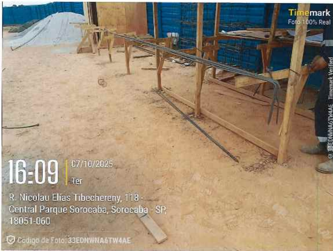
Armação de ferragens de vigas baldrame
