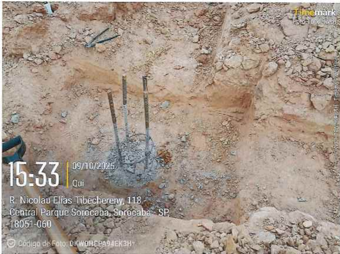
Arrasamento de estacas
