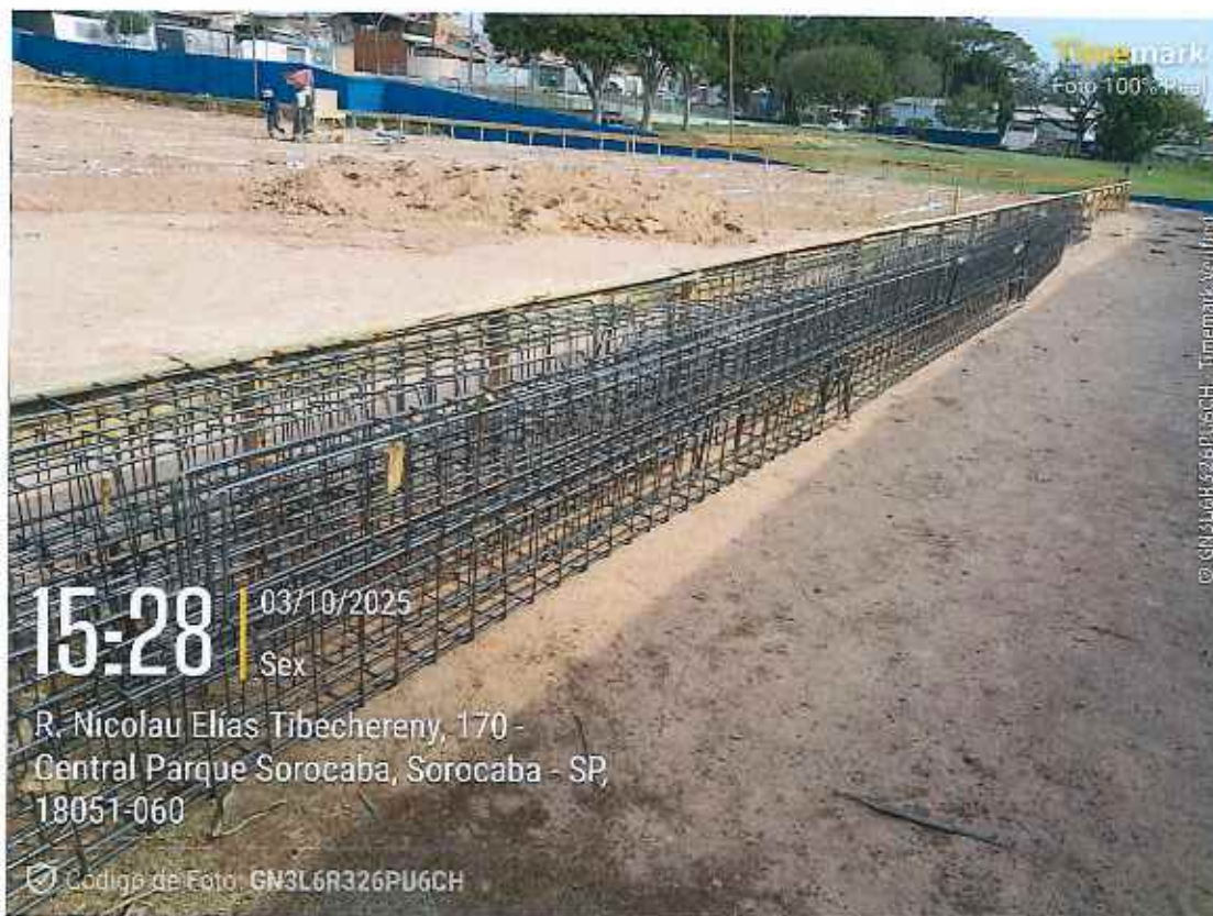
Armação de ferragens de vigas balcrame
