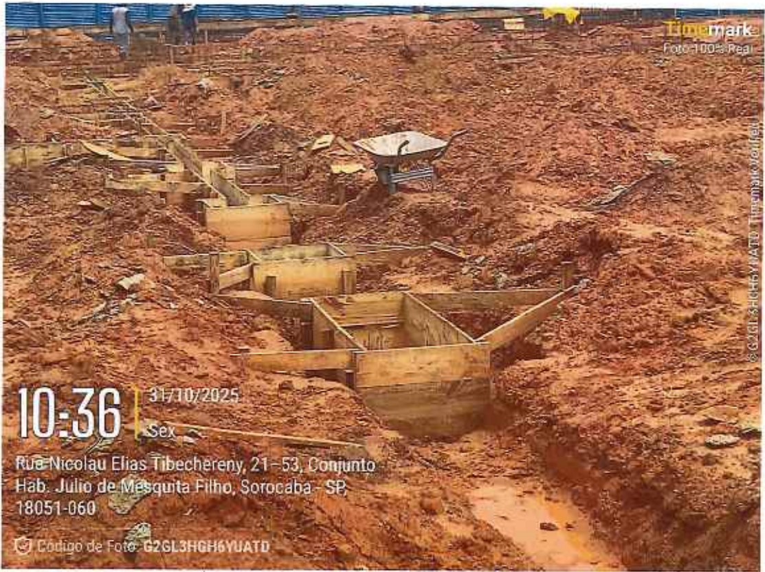
Execução de forma de vigas baldrame
