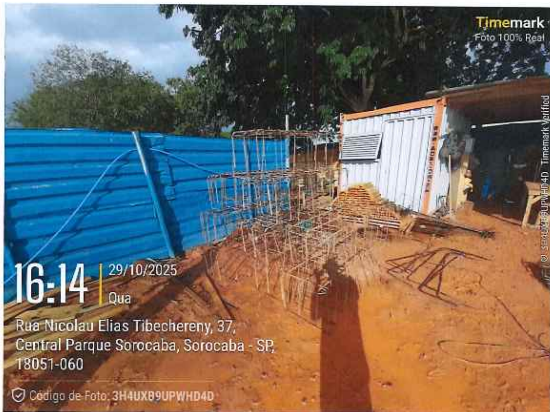
Armação de ferragens de blocos
