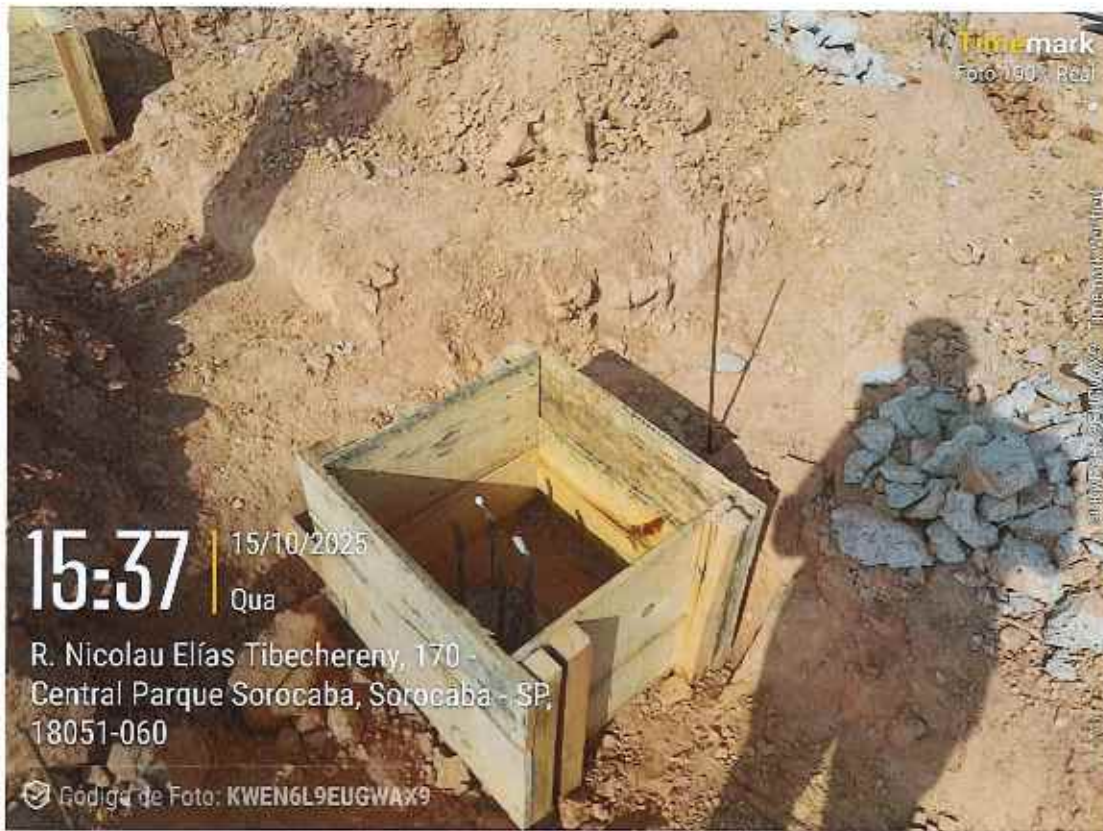
Execução de forma de vigas baldrame
