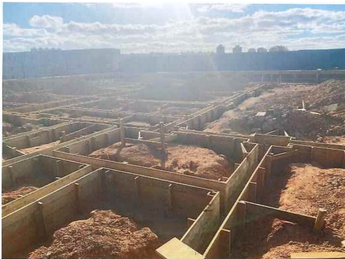
Execução de forma de vigas baldrame
