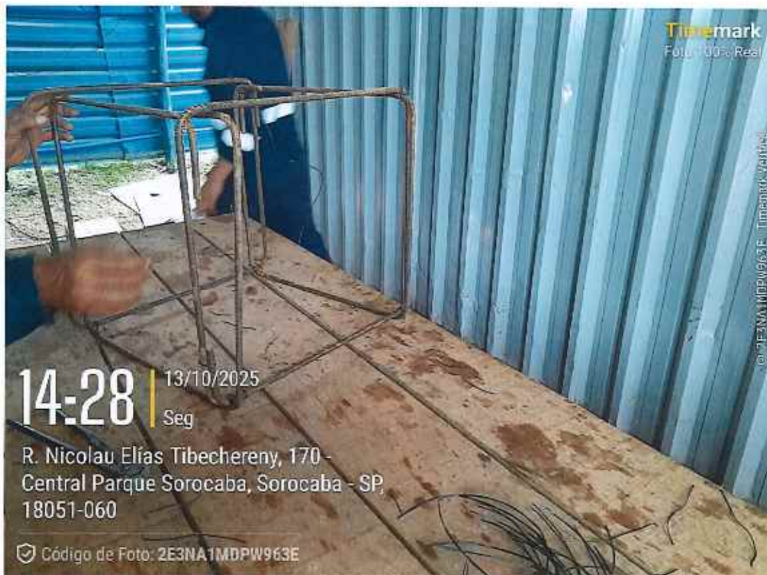
Armação de ferragens dos blocos de coroamento
