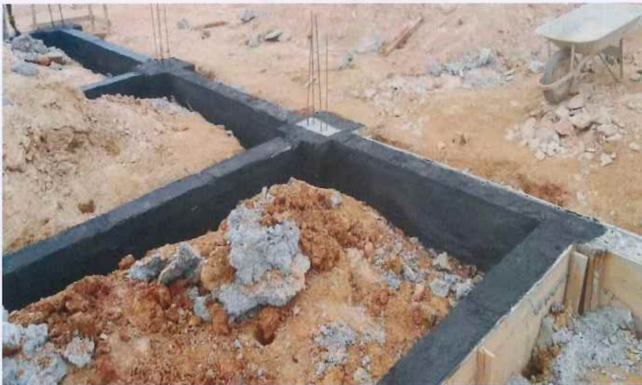
13/11/2025 - Desforma e impermeabilização de baldrame
