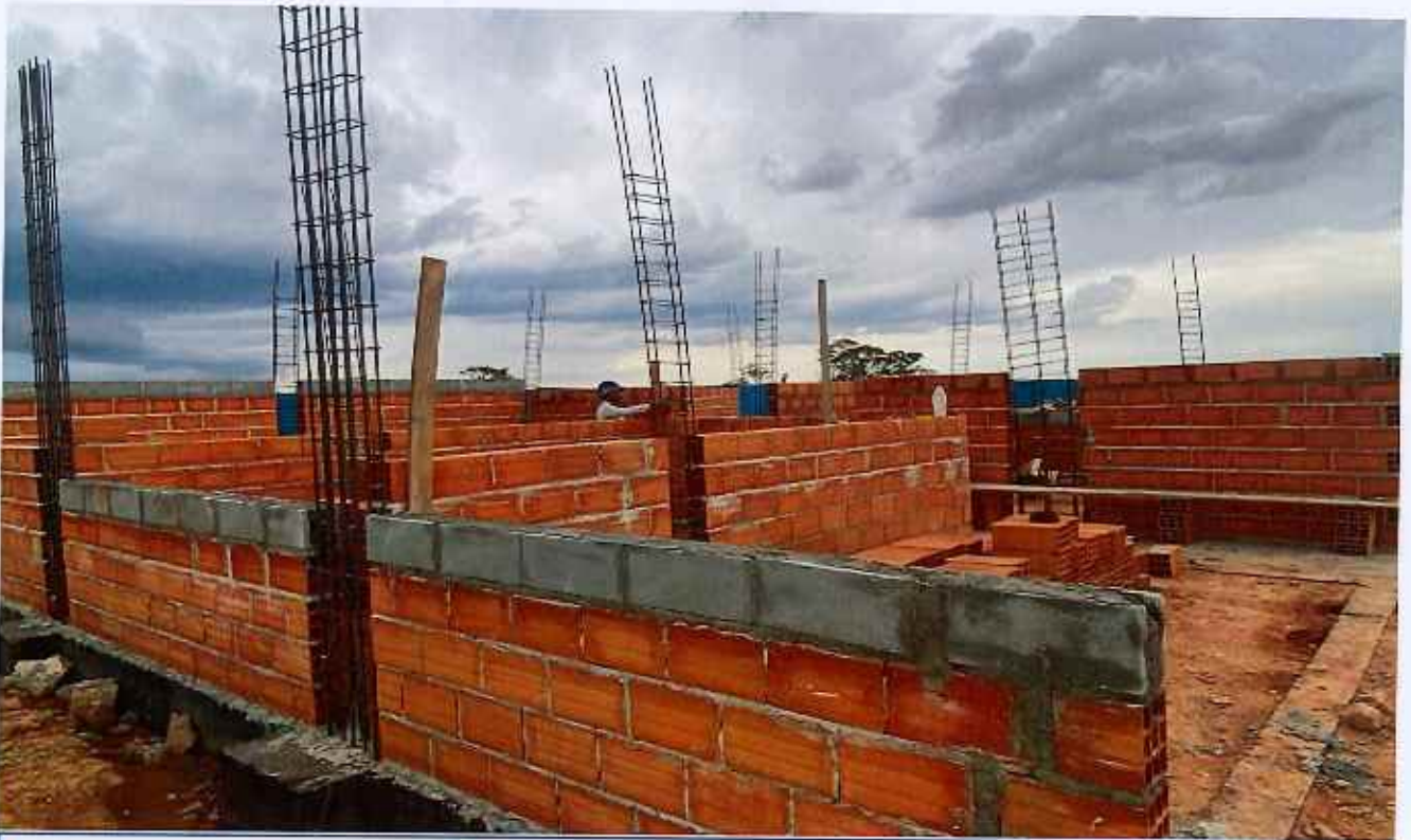
28/11/2025 - Execução de alvenaria
