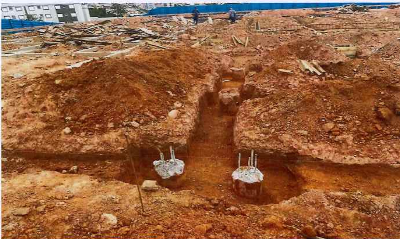
24/11/2025 - Escavação manual de vala
