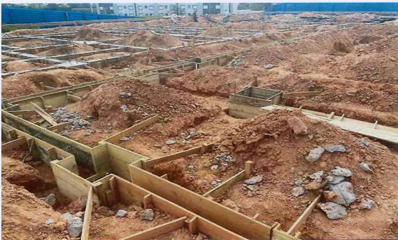
14/11/2025 - Execução de forma de vigas baldrame
