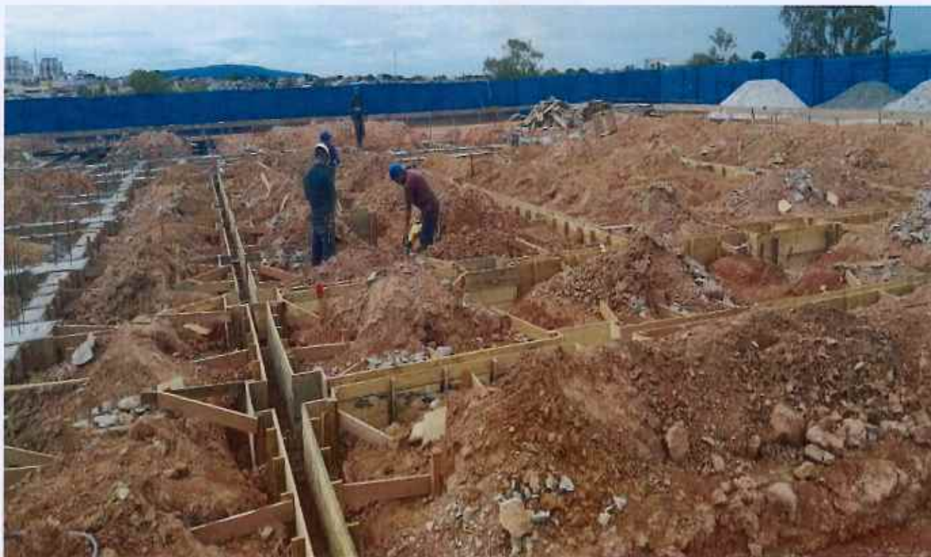
17/11/2025 - Execução de forma de viga baldrame
