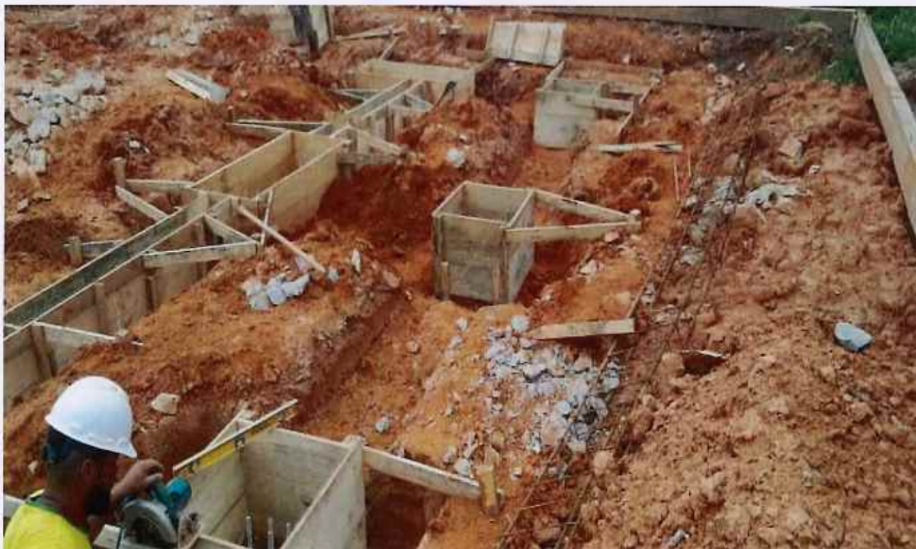
05/11/2025 - Execução de forma e armadura de ferragens de viga baldrame
