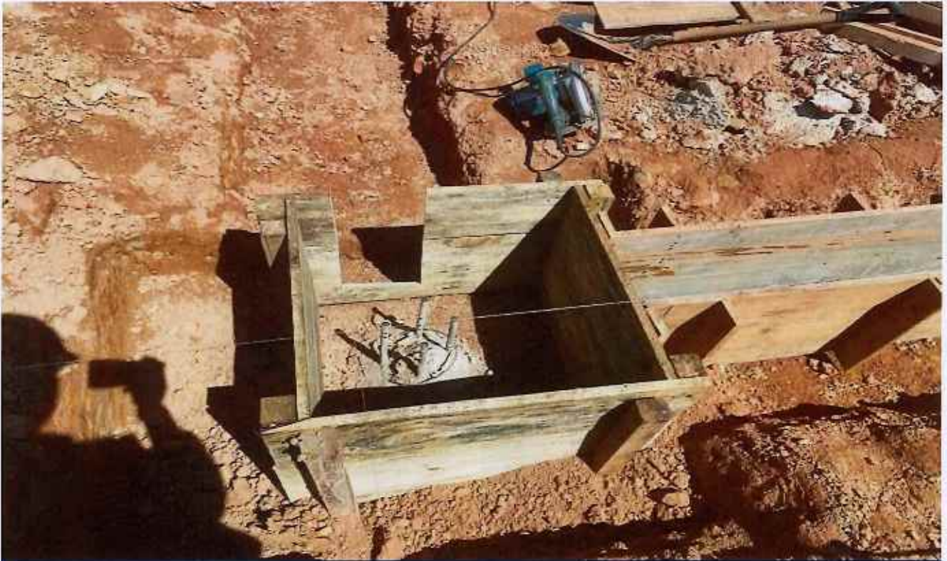
25/11/2025 - Arrasamento de estacas
