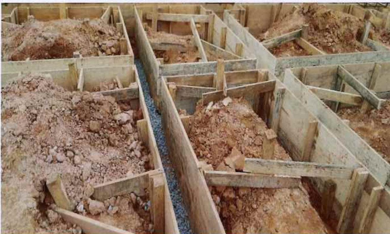
06/11/2025 - Execução de forma de viga baldrame
