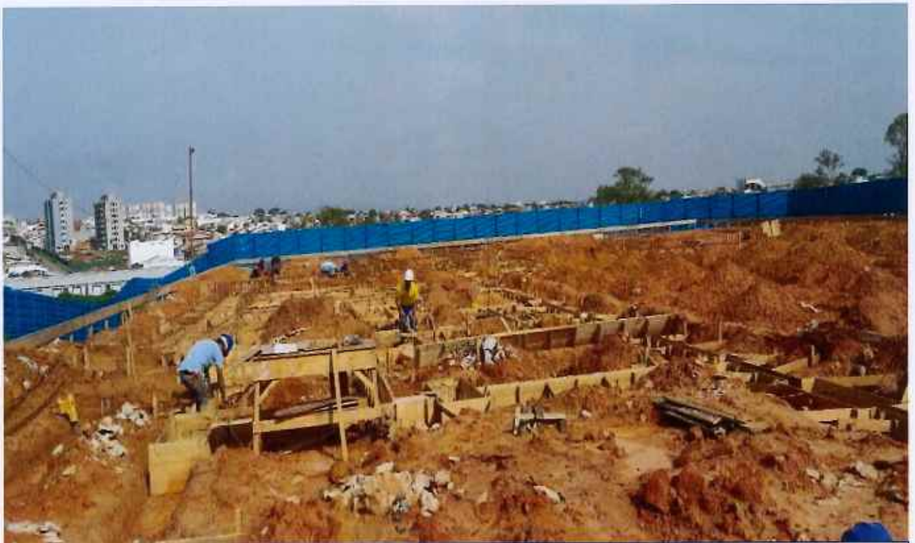
04/11/2025 - Execução de forms de viga baldrame
