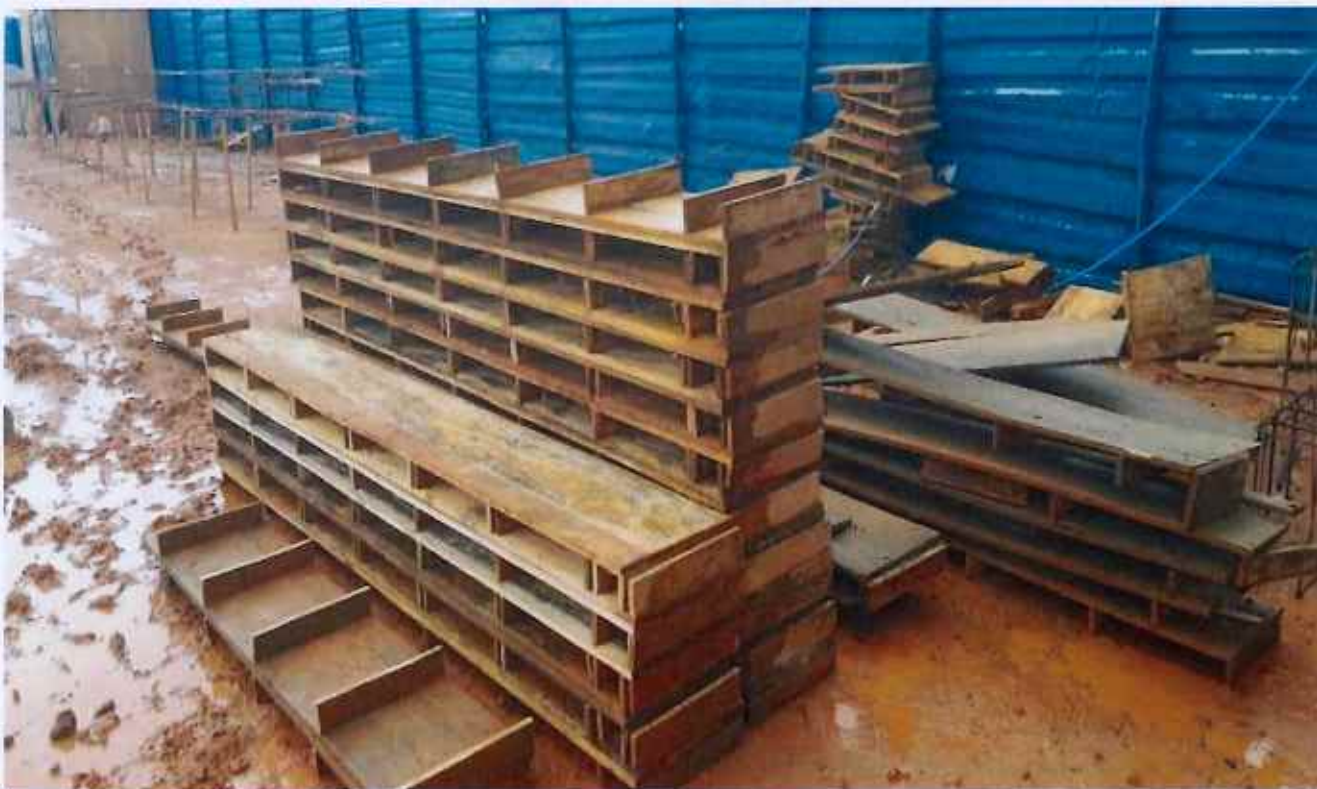
18/11/2025 - Montagem de painéis para forma de viga baldrame
