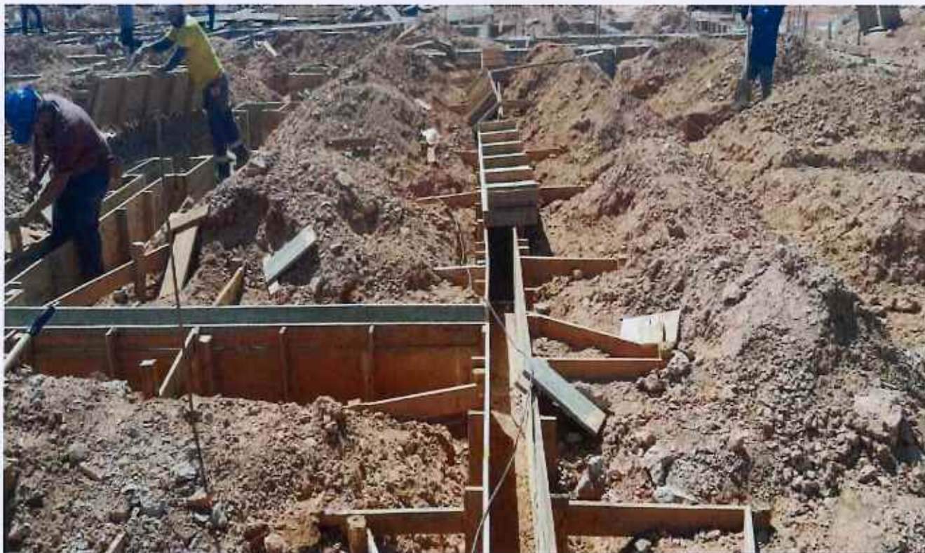
19/11/2025 - Execução de forma de viga baldrame
