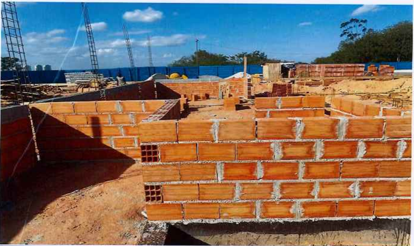
28/11/2025 - Execução de alvenaria
