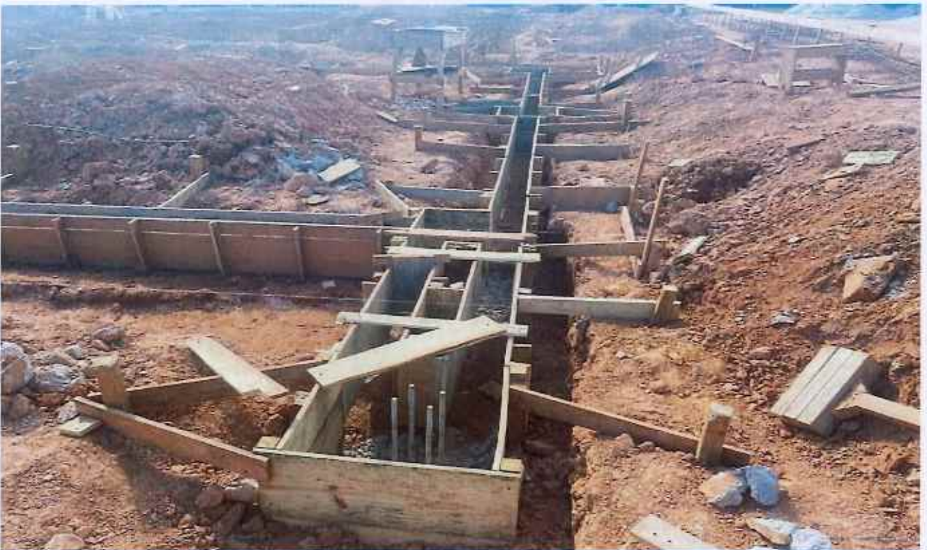
26/11/2025 - Execução de forma de viga baldrame
