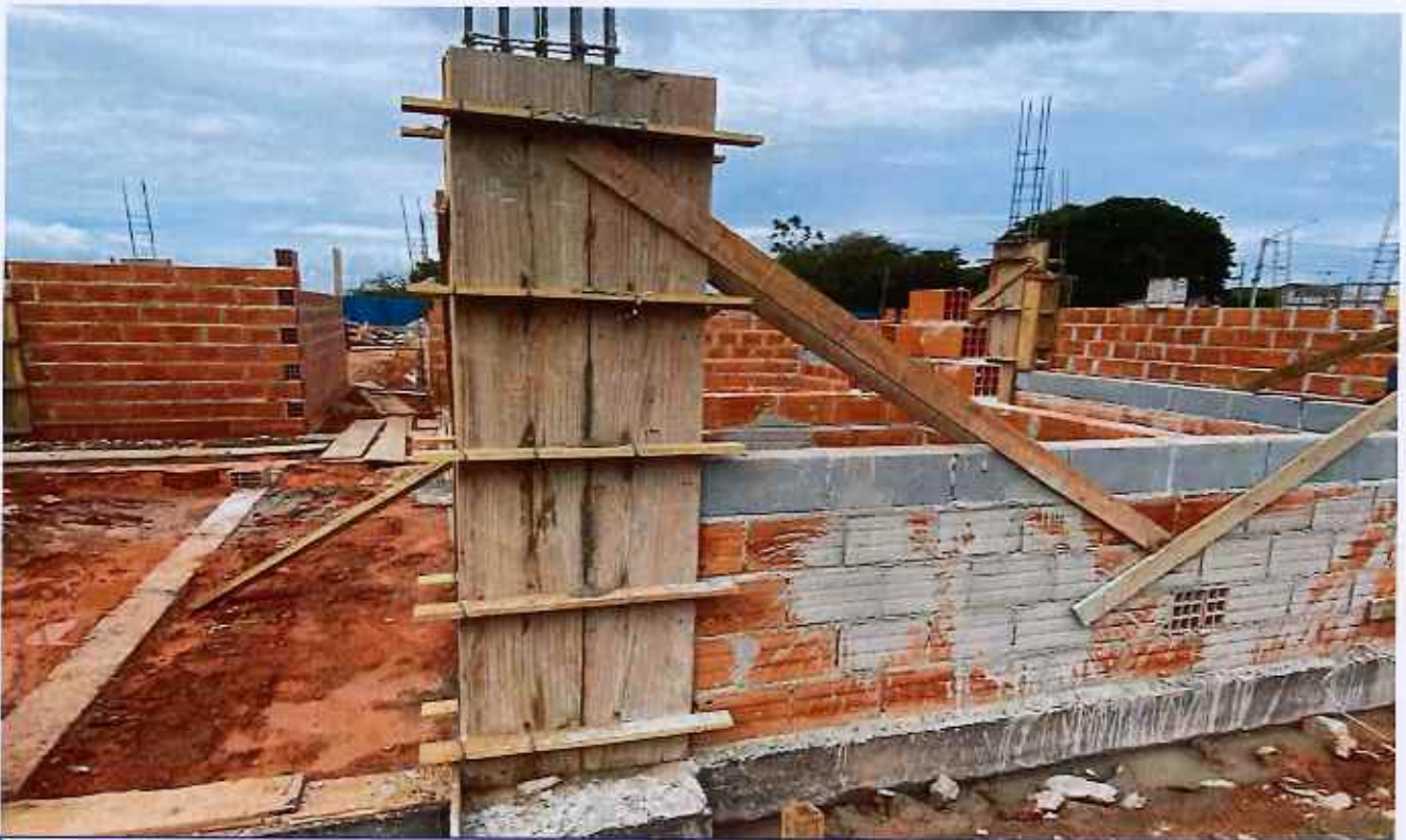
15/12/2025 - Concretagem de pilar
