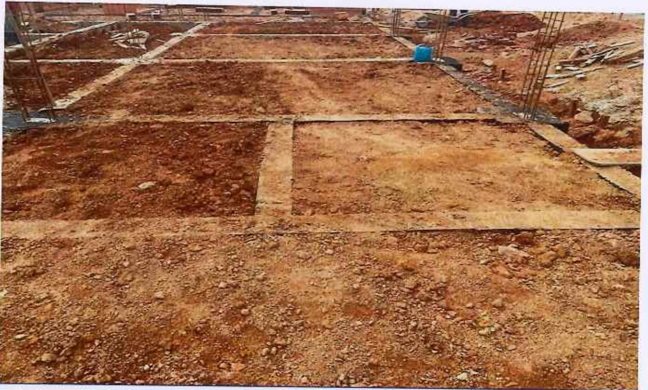
18/12/2025 - Reaterro e impermeabilização
