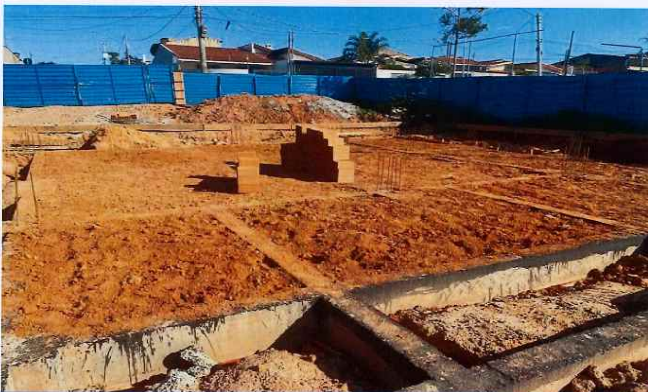
04/12/2025 - Reaterro de vala e piso
