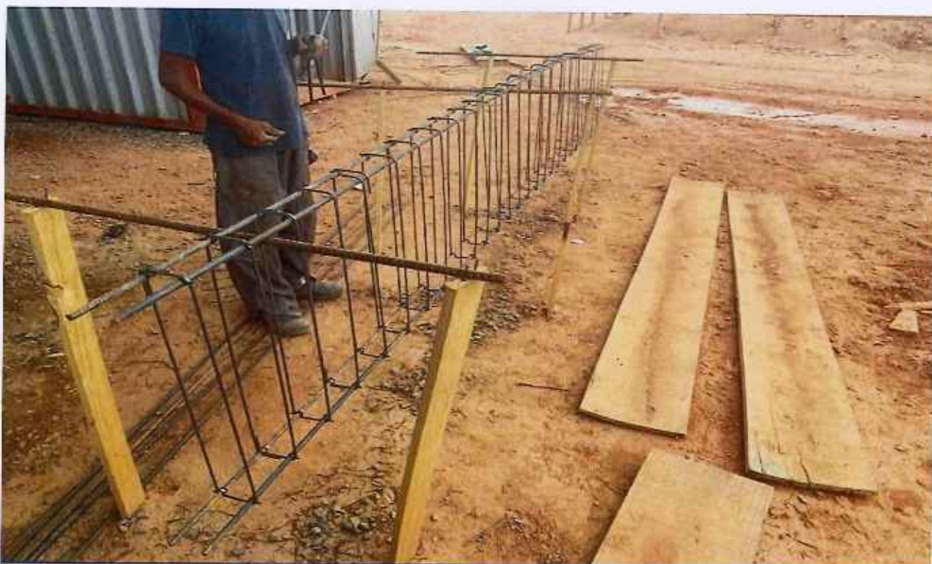
03/12/2025 - Armação de ferragens de pilar
