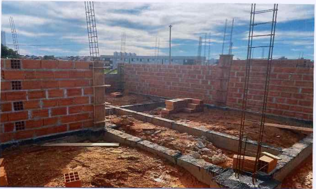
12/12/2025 - Execução de forma de pilar
