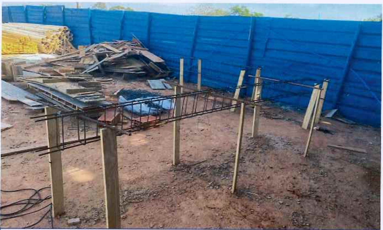
02/12/2025 - Armação de ferragens de pilar
