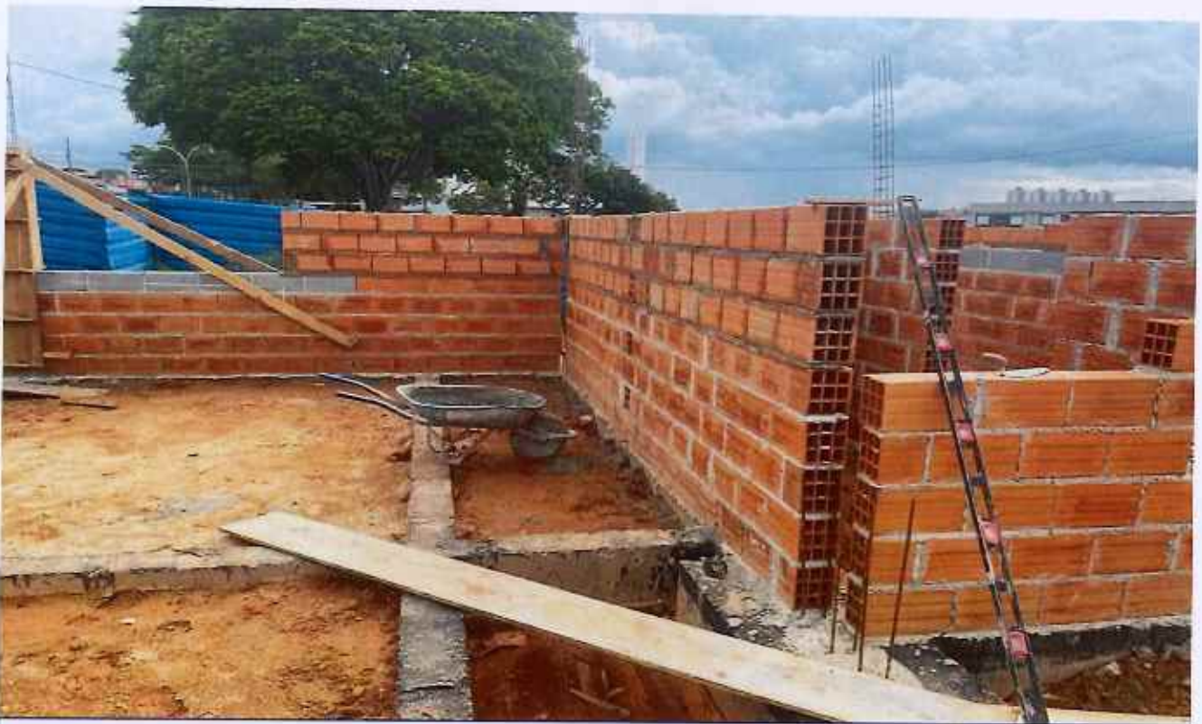
16/12/2025 - Concretagem de pilar
