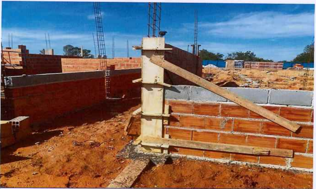
10/12/2025 - Execução de forma de pilar
