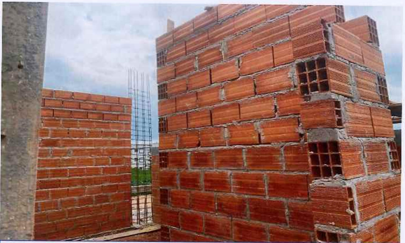
19/12/2025 - Execução de alvenaria
