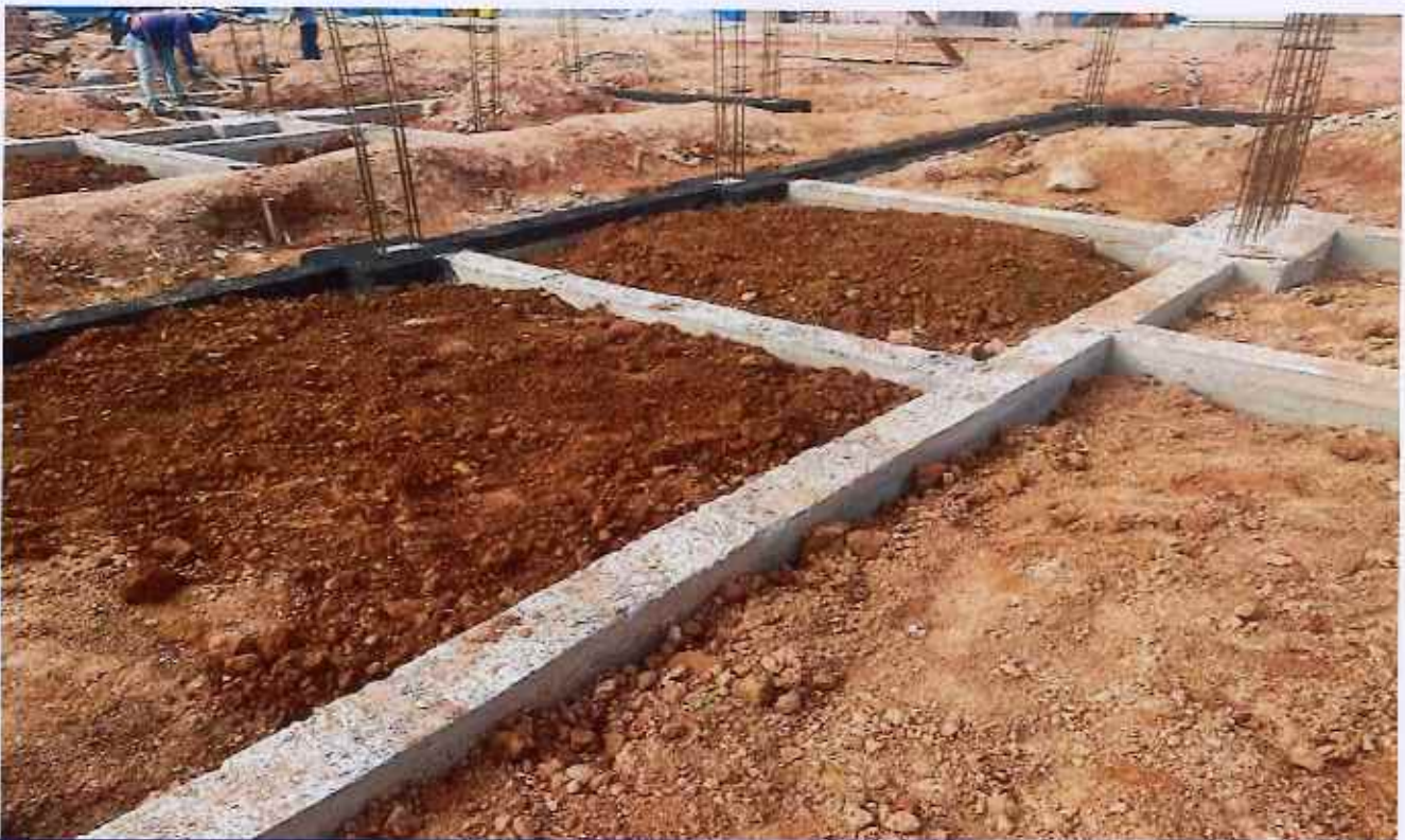
17/12/2025 - Desforma de viga baldrame e reaterro
