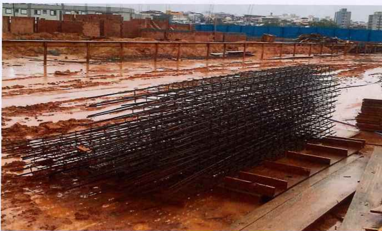
09/12/2025 - Armação de ferragens de pilar
