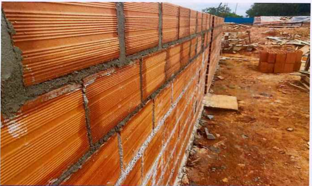
11/12/2025 - Execução de alvenaria
