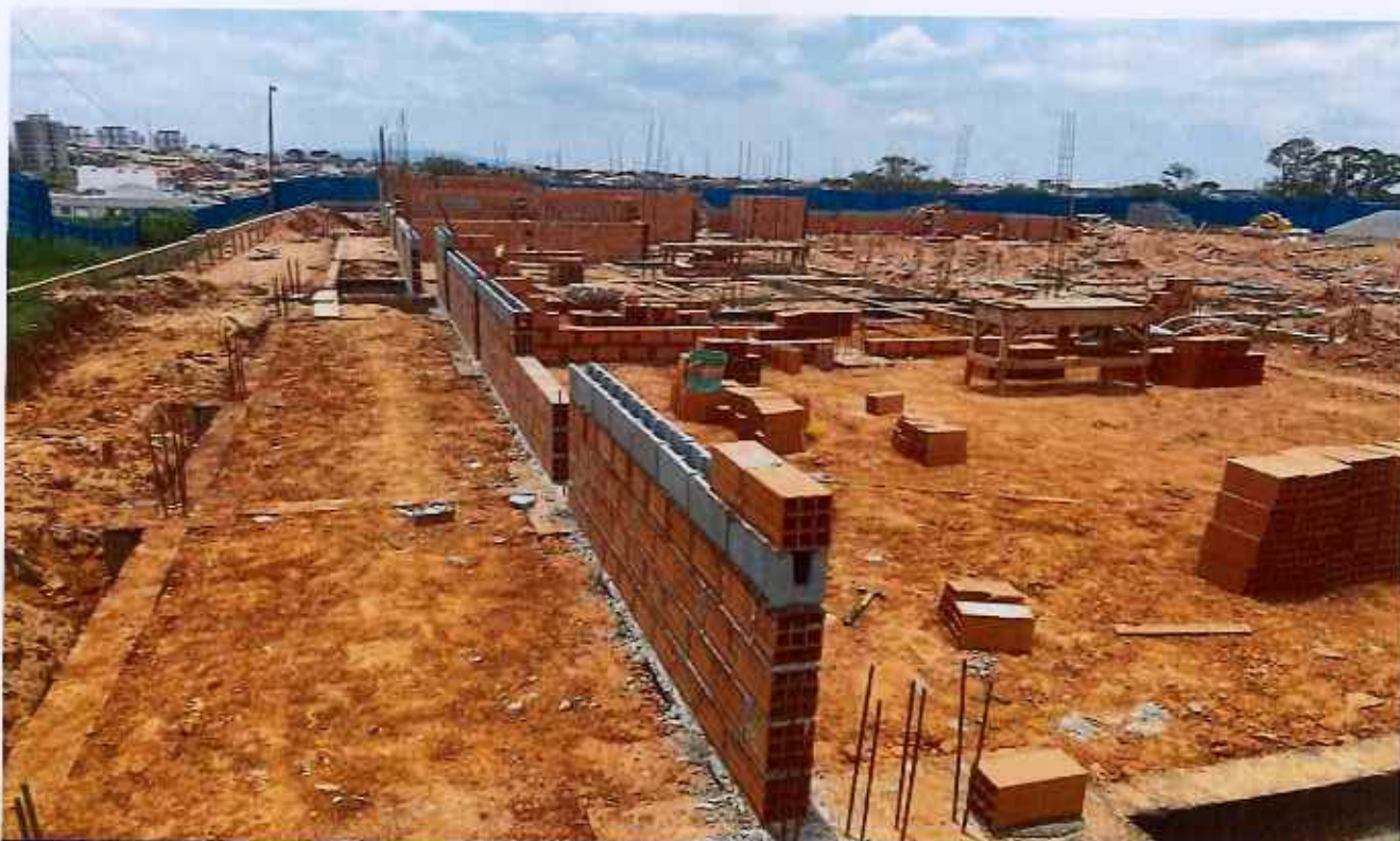
08/12/2025 - Execução de alvenaria
