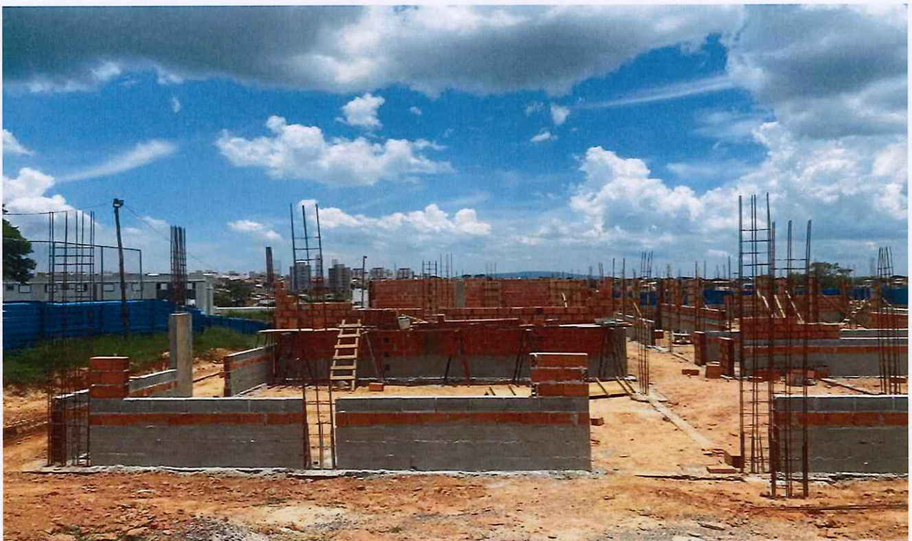
12/01/2026 - Execução de alvenaria
