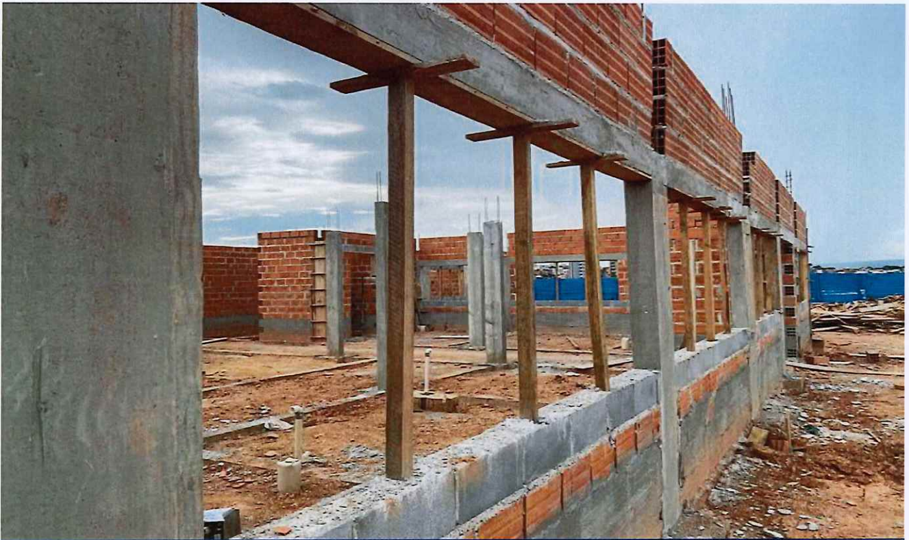
29/01/2026 - Execução de alvenaria
