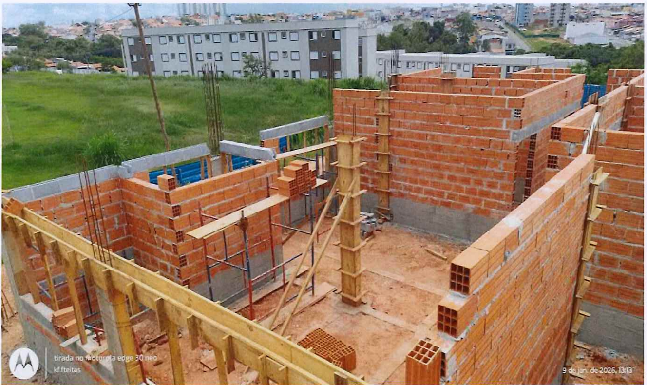
09/01/2026 - Execução de forma de pilar
