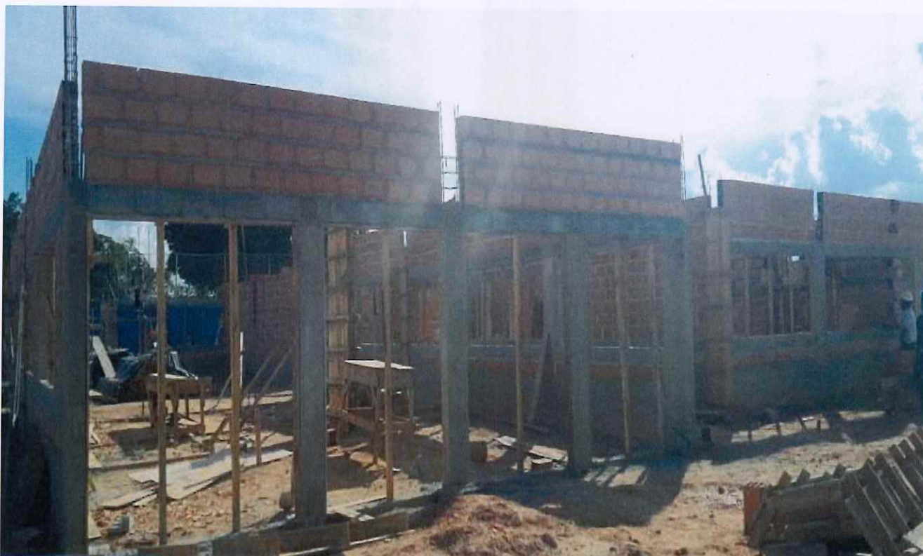
27/01/2026 - Execução de alvenaria
