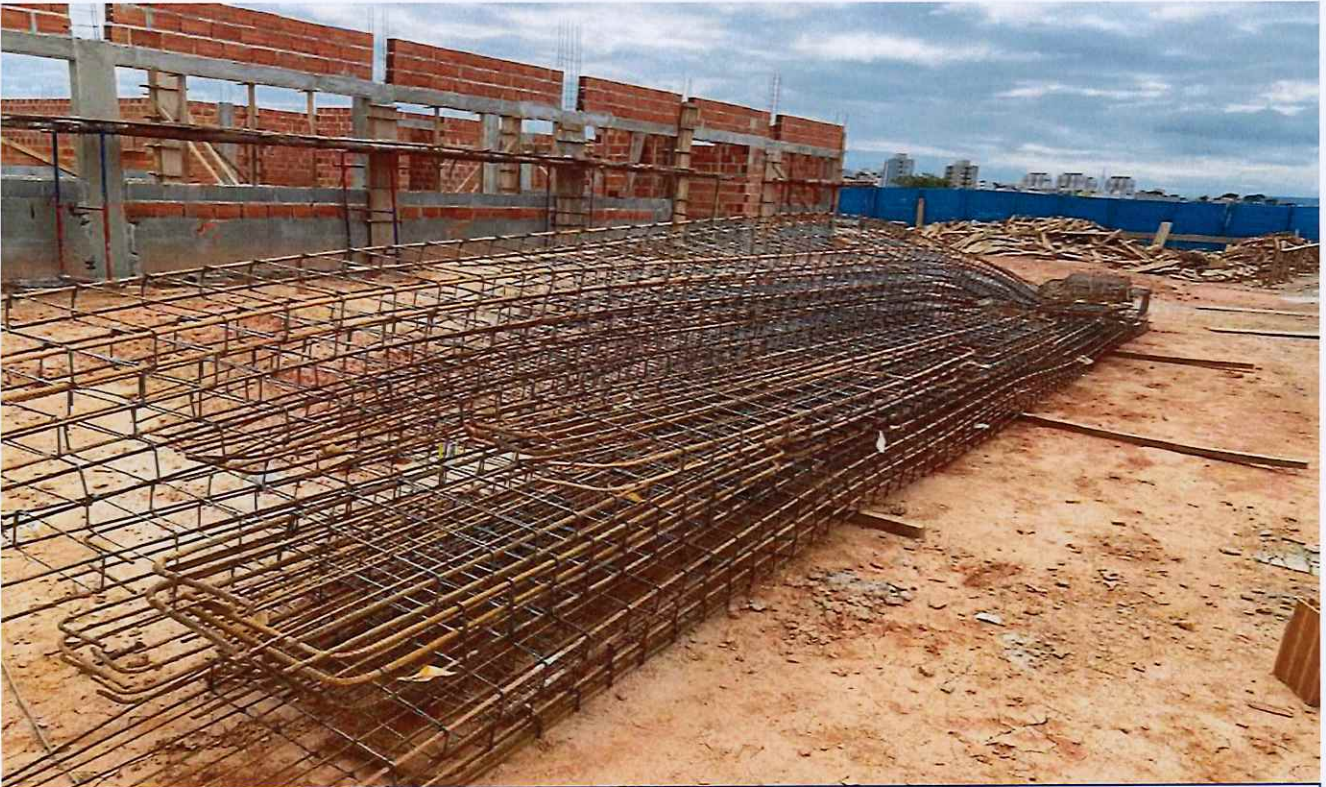
21/01/2026 - Armação de ferragens de vigas de cobertura
