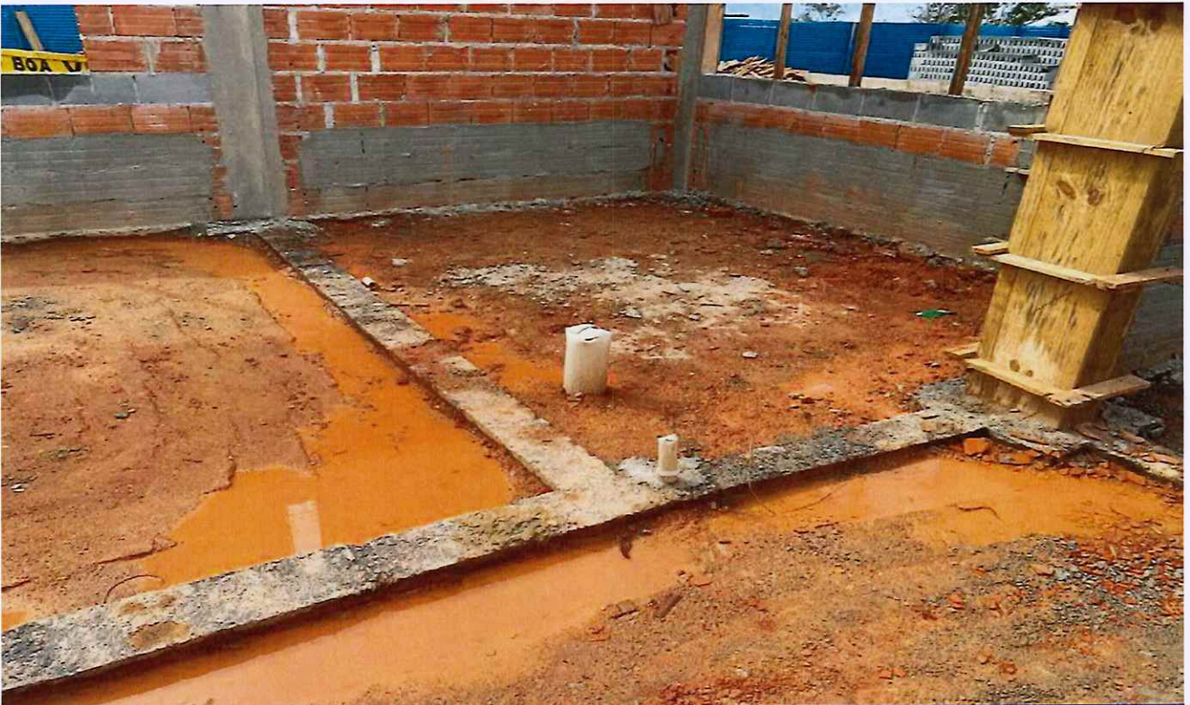
30/01/2026 - Execução de hidraulica
