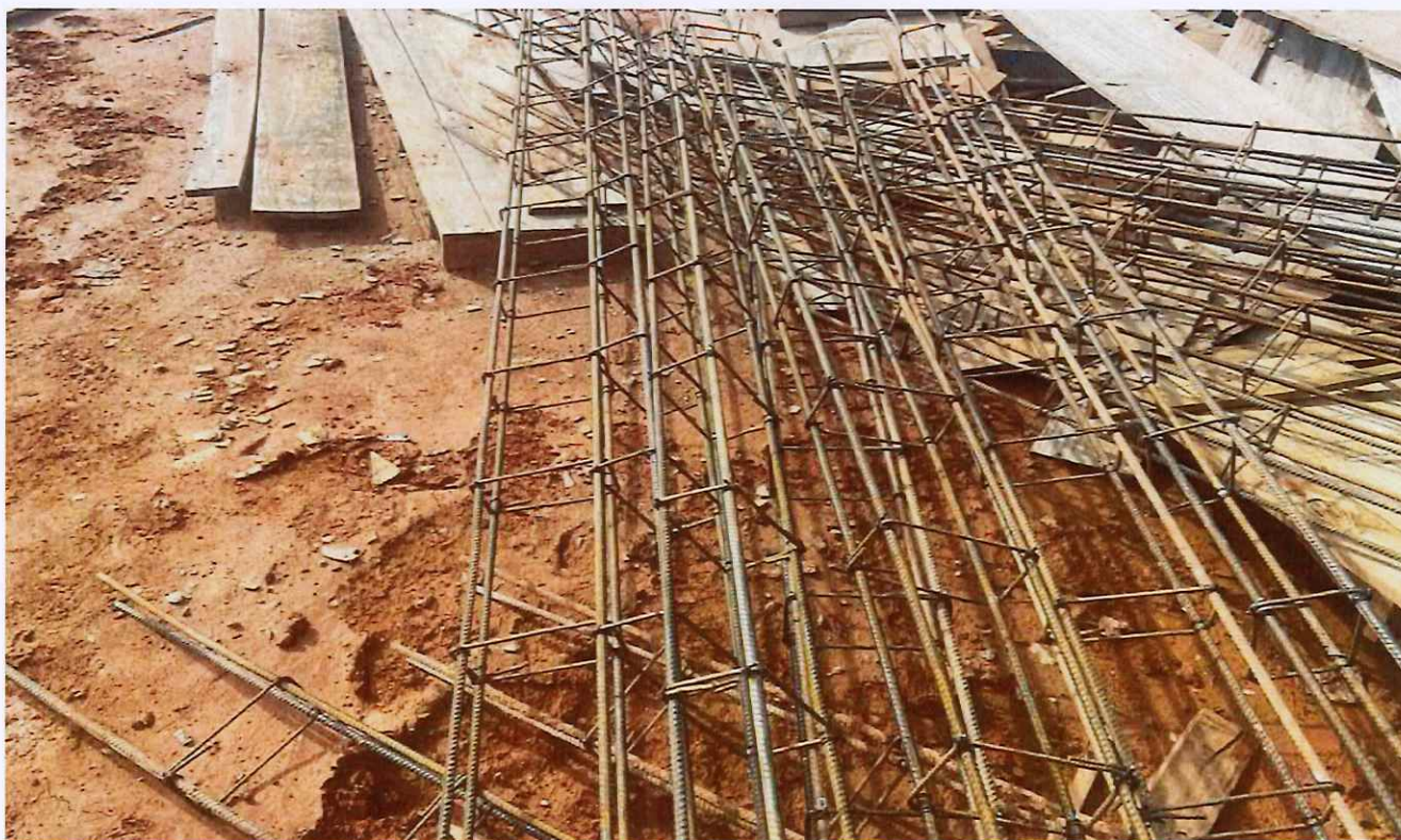
13/01/2026 - Amadura de ferragens de viga
