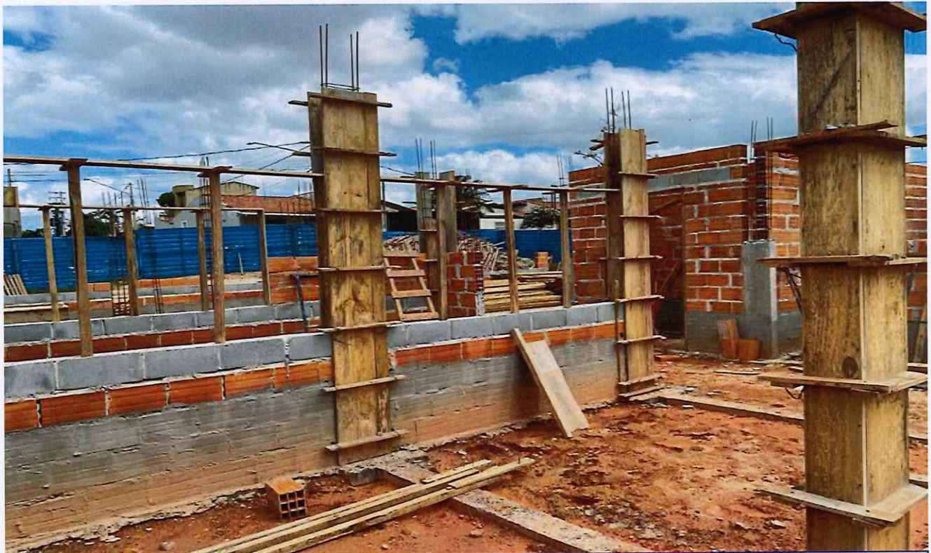
20/01/2026 - Execução de forma de pilar
