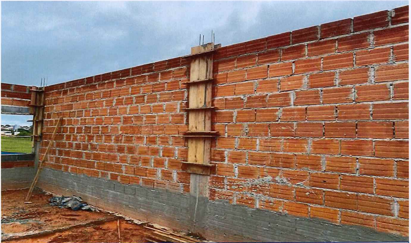
19/01/2026 - Concretagem de pilar
