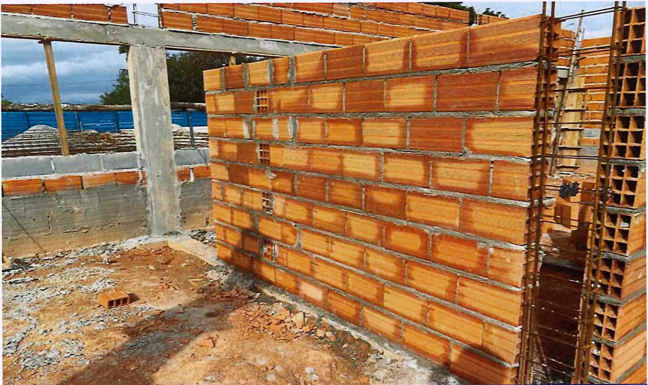
22/01/2026 - Execução de alvenaria
