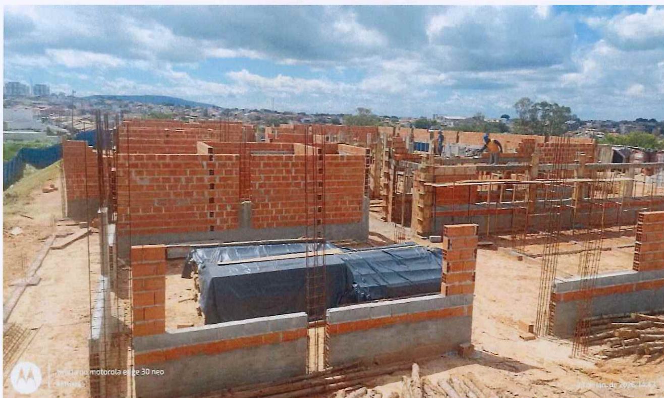
23/01/2026 - Execução de alvenaria
