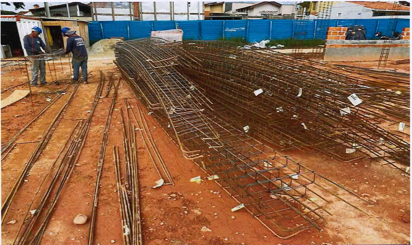
16/01/2026 - Armação de ferragens de viga de cobertura
