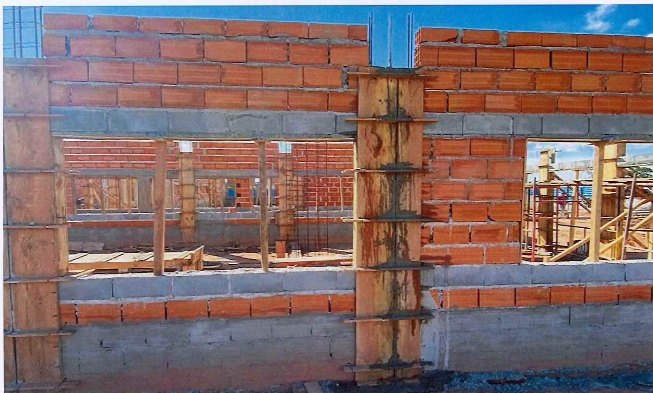
26/01/2026 - Execução de forma de pilar
