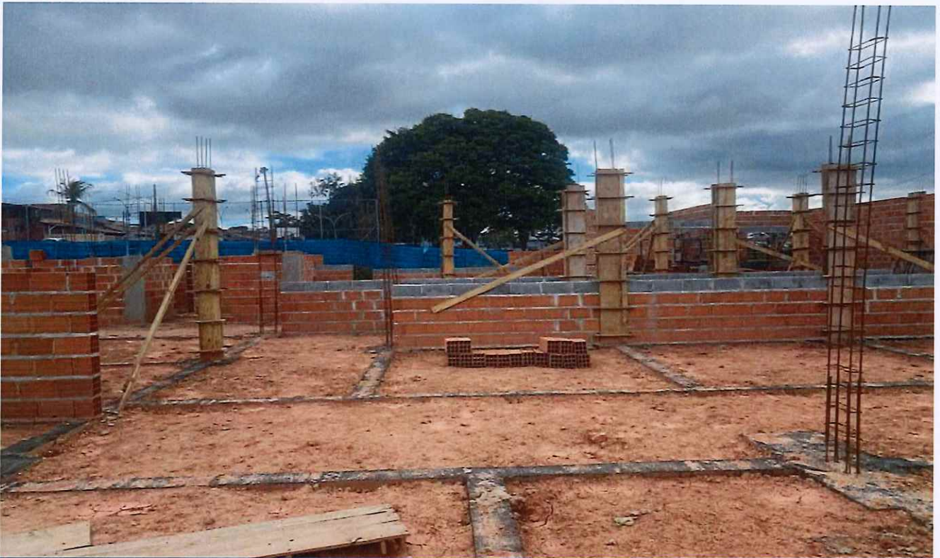
07/01/2026 - Execução de forma de pilar
