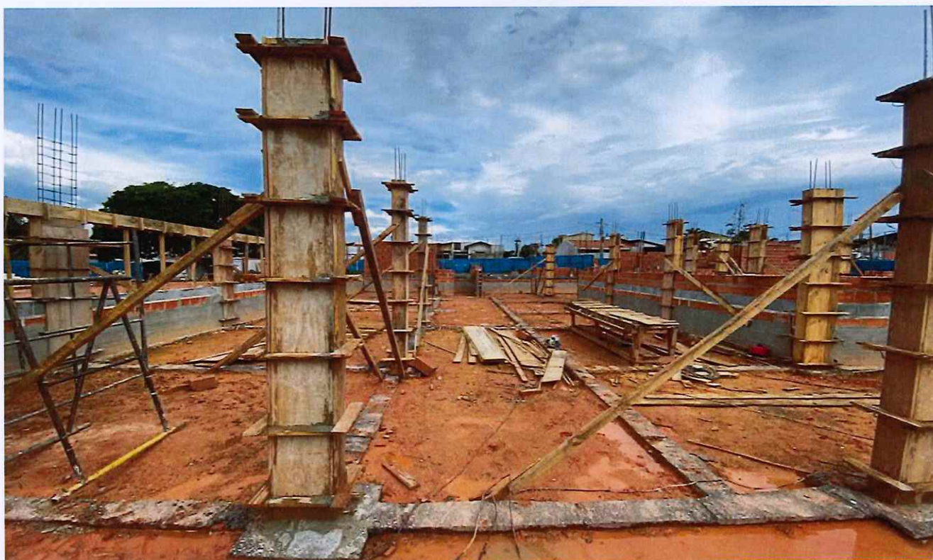
14/01/2026 - Execução de forma de pilar
