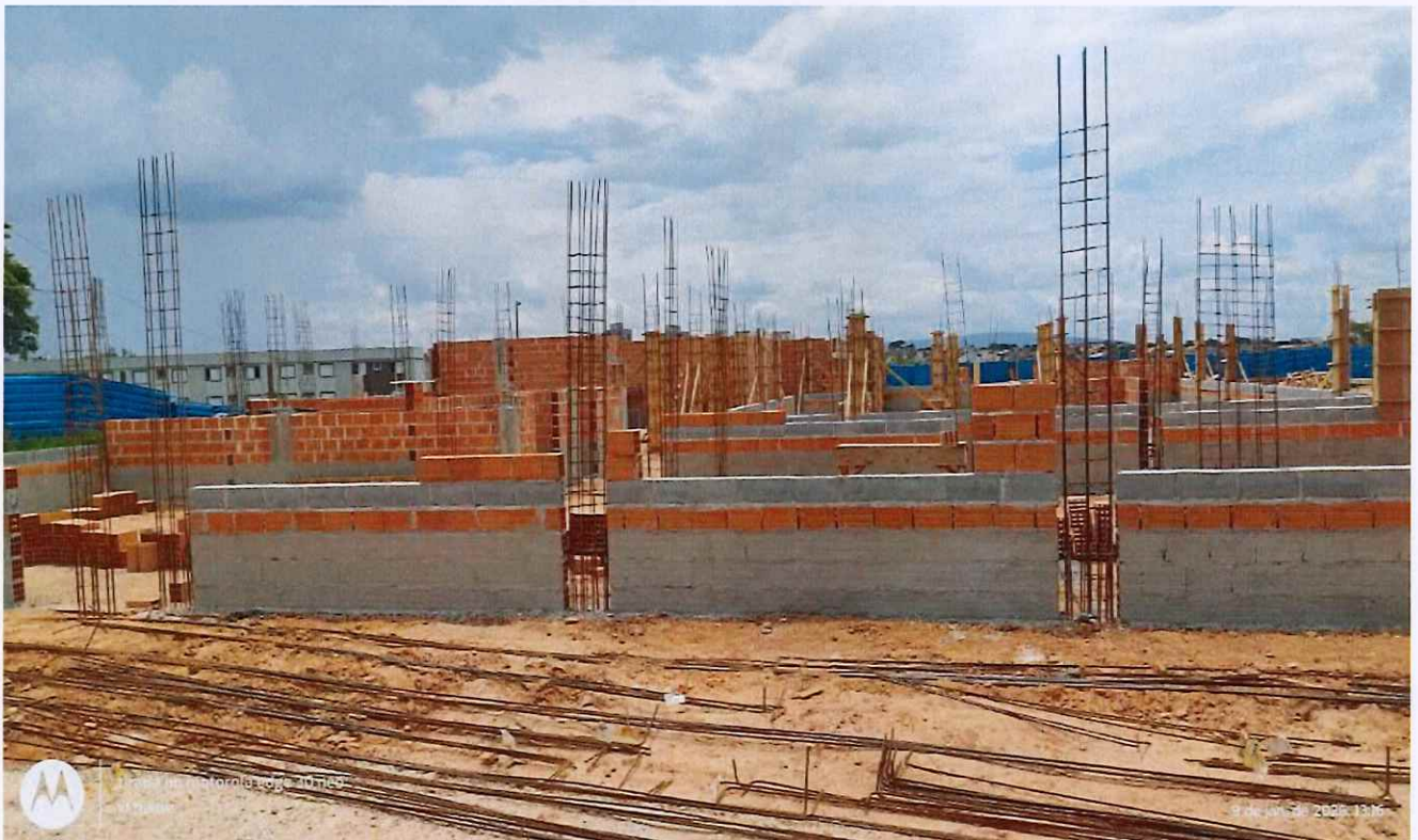
08/01/2026 - Impermeabilização com argamassa polimérica
